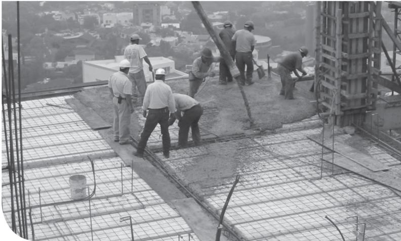
**Sistema VYB:** viguetas, bovedillas, malla electrosoldada y colado de firme de concreto.
