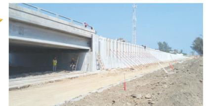
Este muro ha sido diseñado para la contención de terraplenes en pasos a desnivel, sustituyendo a las escamas de concreto reforzadas que resultan caras y lentas en su instalación y producción y, además, de apariencia desagradable a largo plazo.
